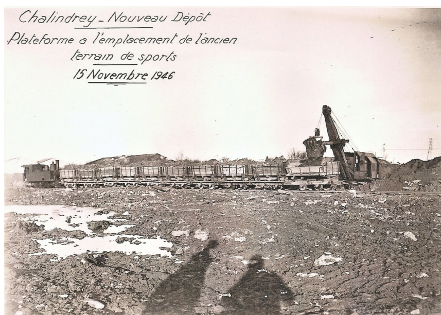
Préparation du terrain avec un train de chantier de type Decauville sur voies étroites (15 novembre 1946)
